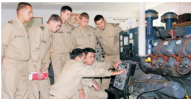
Cabinet mașini și instalații electrice
